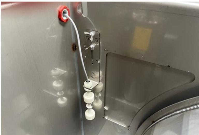
Fixer le contrôleur du filtre sur une paroi du local technique : connecter les câbles d'alimentation du moteur, de la pompe de rinçage, de l'UV à immersion et enfin le câble des capteurs. Le contrôleur possède également une prise qui peut recevoir la pompe de filtration.
